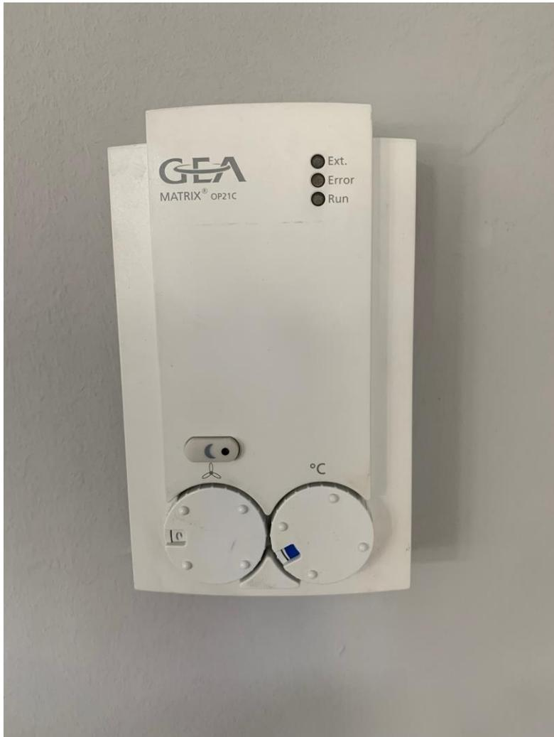
**Klimanlage Stufe 1, Zweite Einstellung 20° C**
